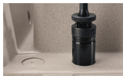
C - Procedere con il completamento del foro
